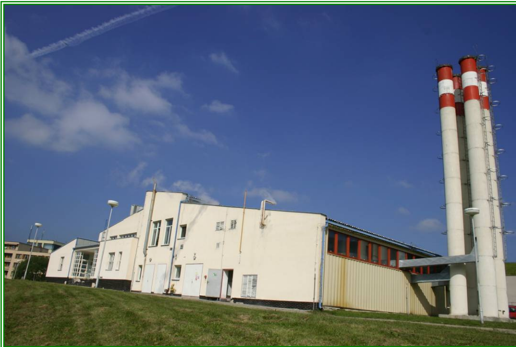
Pohled na prádelnu s kotelnou
