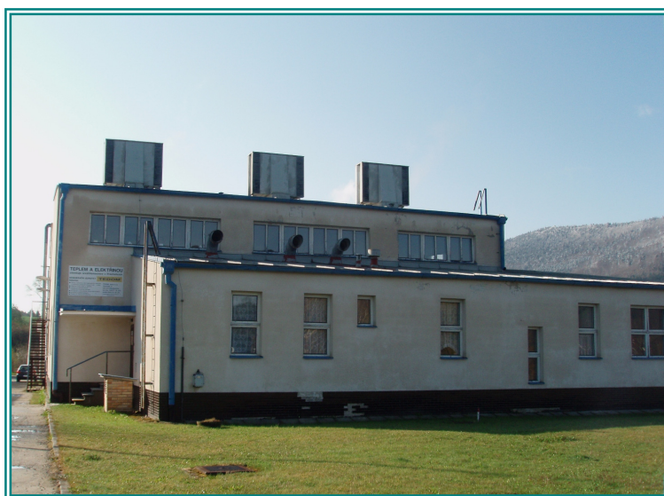
nemocniční prádelna (budova č.2)
