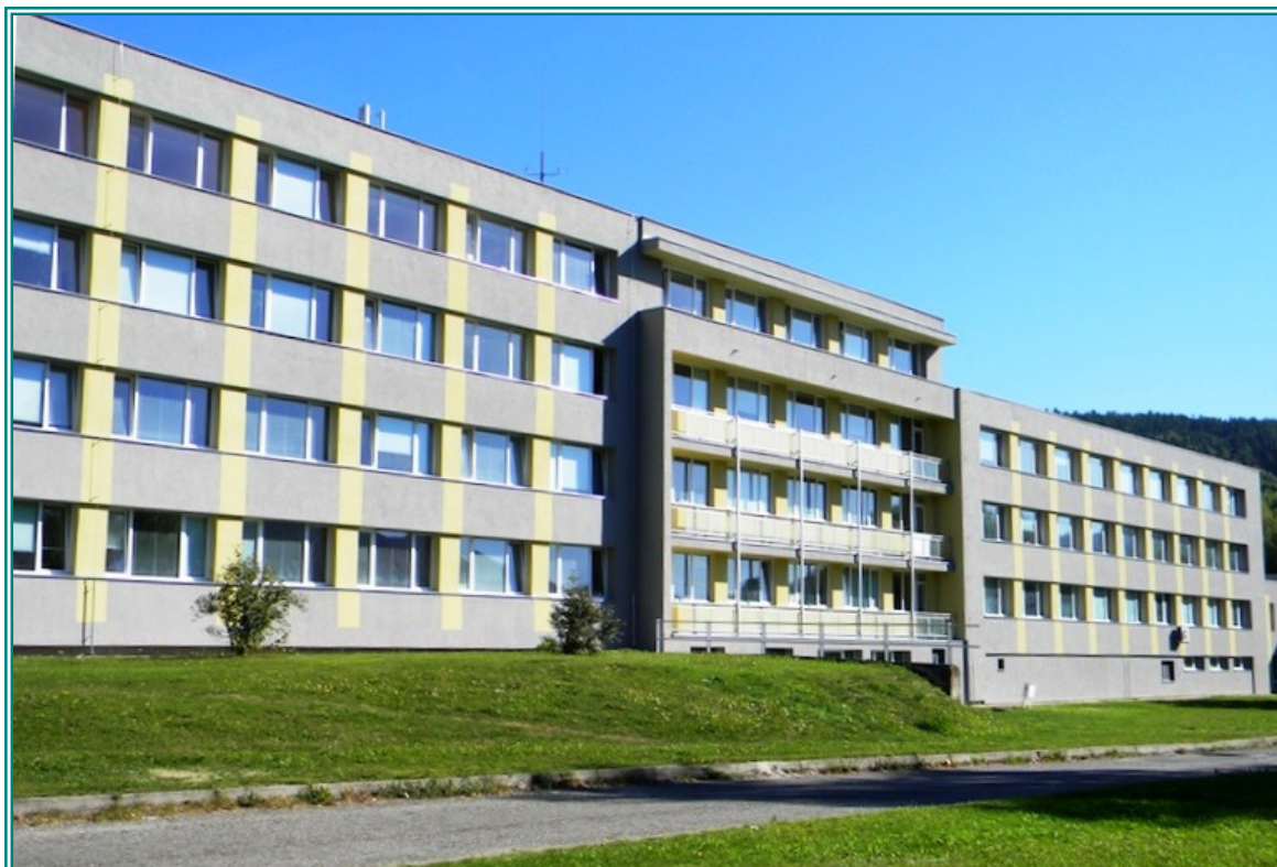
západní strana interního a gynekologicko-porodnického oddělení (budova č.21a), zcela vpravo budova 21b se střediskem hemodialýzy, vedení společnosti a porodních sálů
