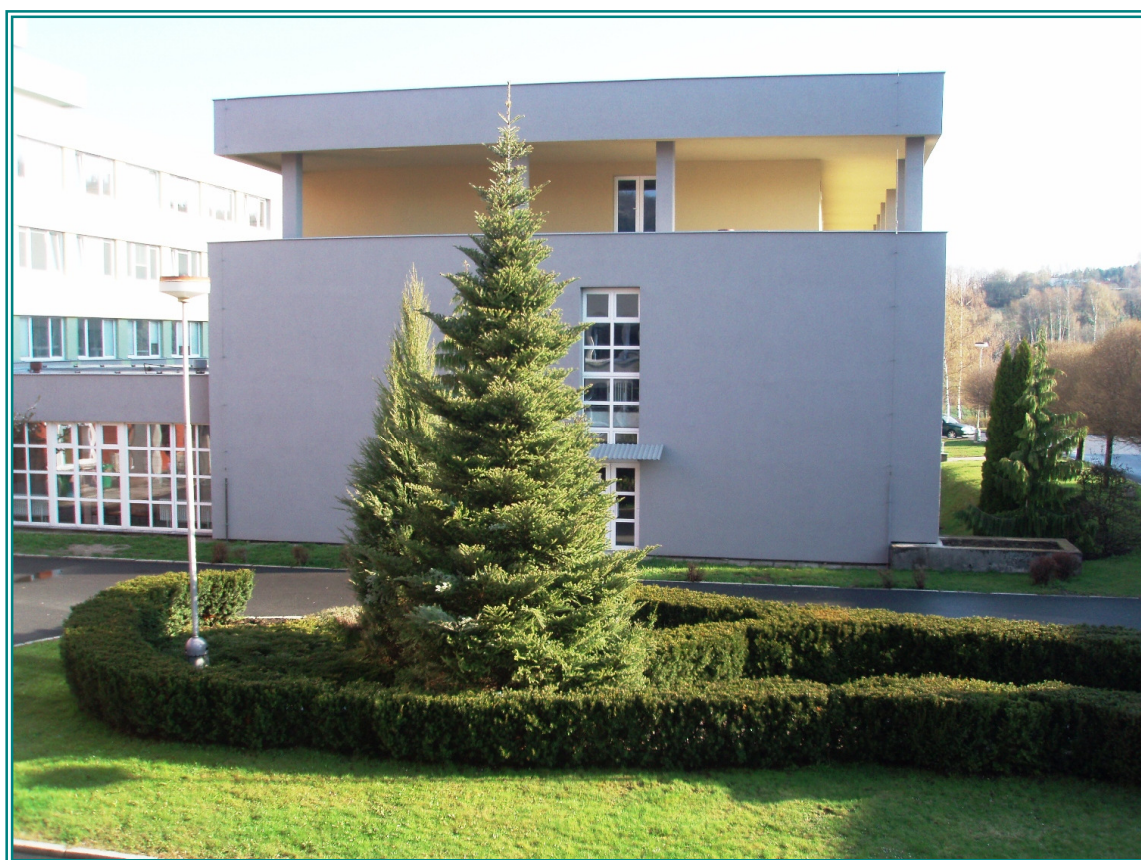
upravené prostranství před hlavní vchodem – v pozadí budova č. 24 s dětským oddělením a stanicí JIP
