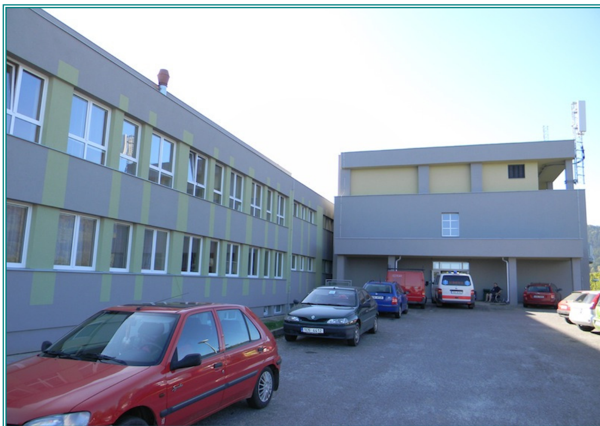
zadní vchod areálu nemocnice (budova č.20), vlevo objekt č.22 s RDO a COS
