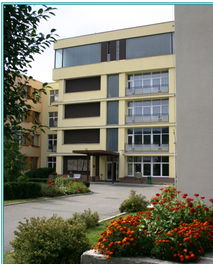
původní stav před rekonstrukcí
