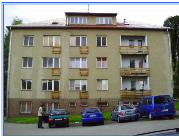
bytový fond nemocnice – ubytovna ve městě, která by měla projít v r.2013 rekonstrukcí zateplení pláště a výměny oken;
