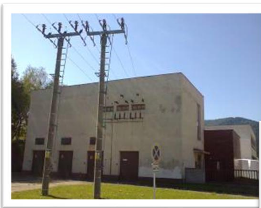
původní stav trafostanice, staré dieselagregáty
